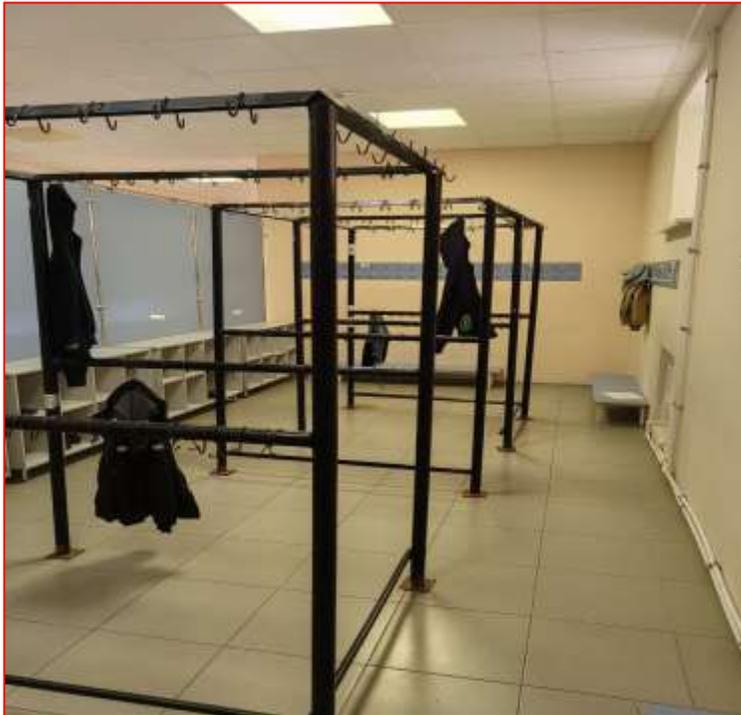
Стойки самодельные, не имеют фиксированного крепления, крючки из проволоки
